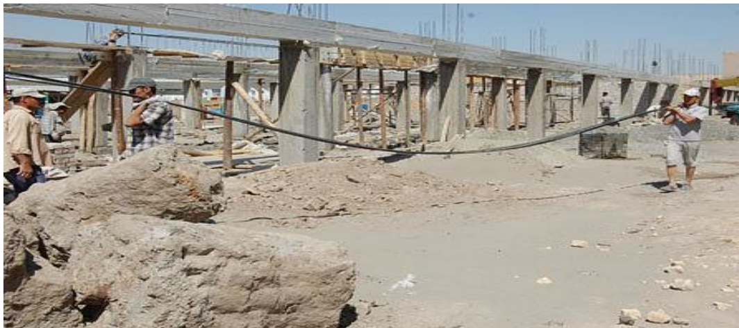
6.1.-rasm. Qurilishda temir-beton konstruksiyalari
